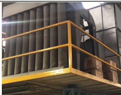
FOTOGRAFIA 10. FILTRO DE MANGAS APLICACIÓN DE PINTURA ELECTROESTATICA
